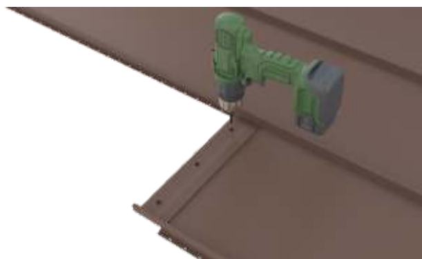
fig.37 Fixarea racordului de îmbinare
