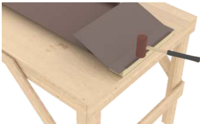
Fig.8 Folosirea ciocanului de plastic pentru presarea uniformă a falțului
