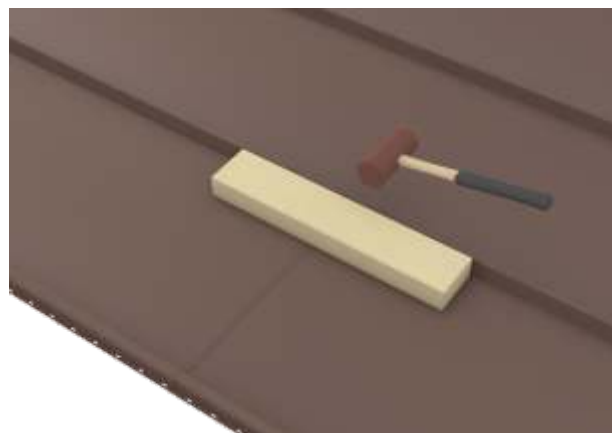
fig.39 Clipsarea și presarea definitivă cu ajutorul bucății de lemn și a ciocanului de plastic
